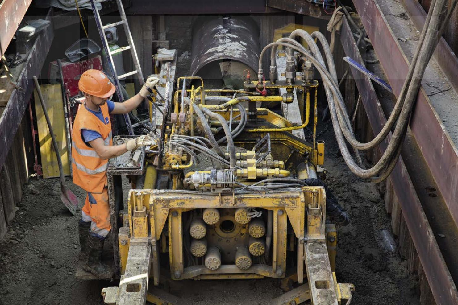
L'opérateur dirige la poussée du tube depuis le fond de la fouille, à 4 m de profondeur.
