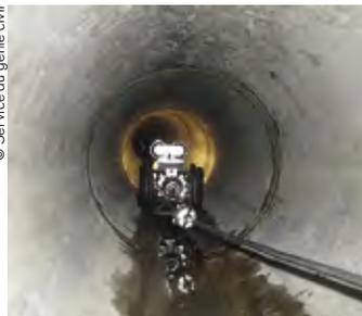
Caméra d'inspection télévisée à l'intérieur d'une canalisation.
