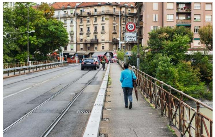
Revêtement dégradé, barrières rouillées, trottoirs trop étroits : le pont de Carouge nécessite d'importants travaux de rénovation.
