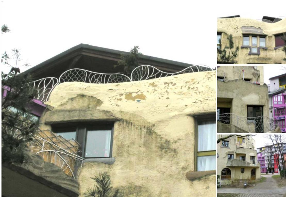
▪ Suite à des interventions répétées, il s'avère nécessaire de trouver rapidement une solution pour l'étanchéité des parapets des balcons et attiques. L'eau s'est infiltrée au fil des années entre le crépi extérieur et le complexe d'isolation, provoquant la détérioration de l'enveloppe extérieure.
