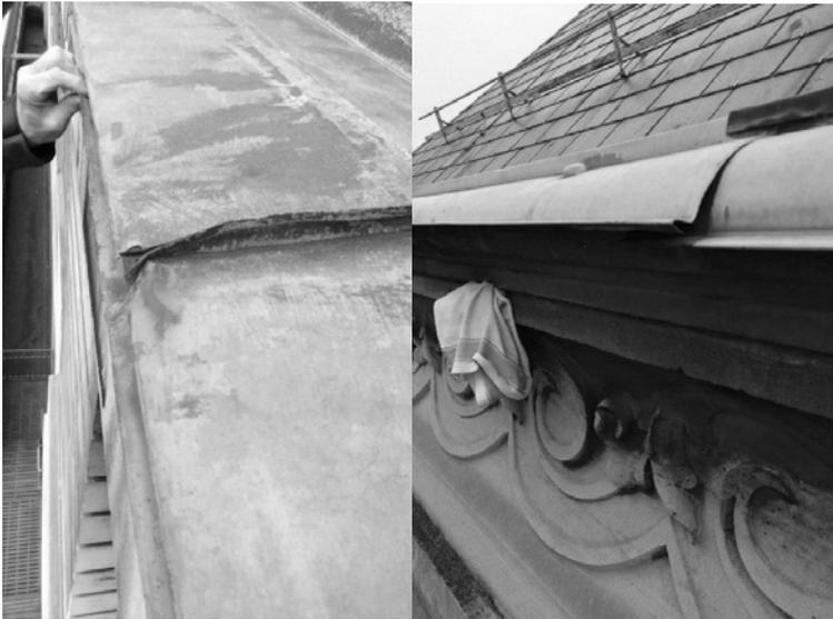
Corniches et toiture – à gauche, soudures déchirées, à droite élément se décrochant
