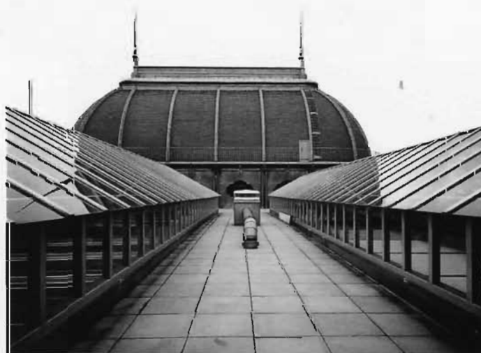
Vue de la coupole restaurée et des nouvelles verrières
