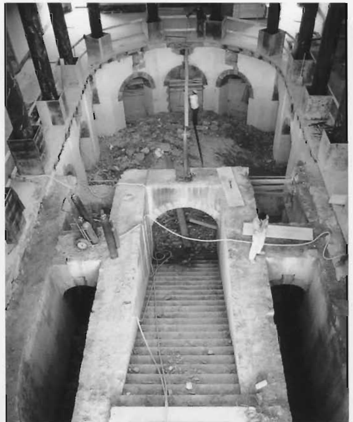
Première travée en sous-sol de l'escalier monumental jamais achevé, démolie lors des travaux de restauration, juillet 1986
