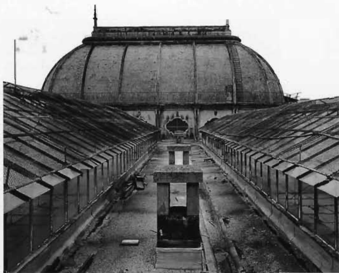
Vue de la coupole et des verrières originelles, état avant restauration
