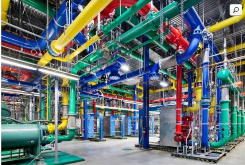
Toujours dans le datacenter de The Dalles, des tuyaux acheminent et évacuent l'eau. C'est le réseau de refroidissement du centre de données : des tuyaux bleus pour l'eau froide, et des tuyaux rouges pour l'eau chaude. Logique.
