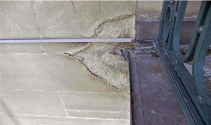
Ci-dessus, on voit que ce phénomène conjugué de concentration des eaux en des points précis par le système de ferblanteries et de rejaillissement (voir sous point **3**) peut engendrer des dégâts ponctuellement importants.
