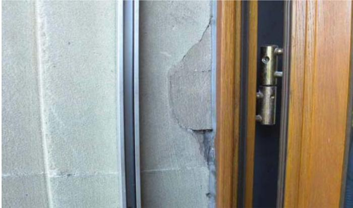
La réparation ci-dessus est un exemple des nombreux rhabillages réalisés avec un mortier à base de ciment, beaucoup trop dur pour la molasse environnante (il a visiblement été cassé lors de la pose de la nouvelle menuiserie).
