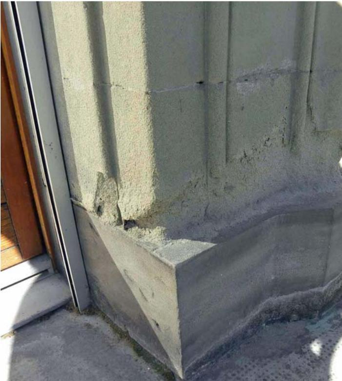
Ci-dessus un exemple de dégradation due au rejaillissement des eaux sur la saillie de la base en grès dur du montant mais dont la dureté permet quand même à l'eau de rebondir dessus et de surcharger en humidité la 1<sup>ère</sup> assise en molasse qui se dégrade plus vite.
