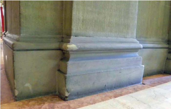
Il y a quelques temps, un dégât d'eau au 1<sup>er</sup> étage a fait des dégâts sur certains parements en molasse du lobby.
