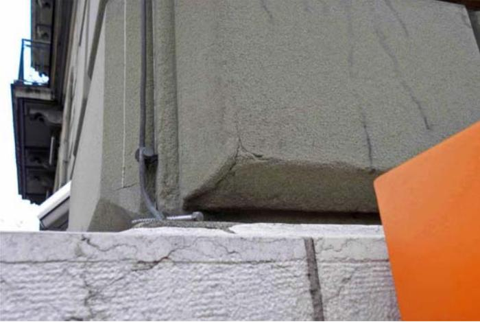
Ci-dessus, conséquence du rejaillissement des eaux de pluie sur le socle en calcaire dur.
