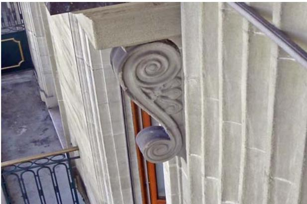
Sur la photo ci-dessous (parement du rez-de-chaussée en façade Nord), on constate les taches d'une projection d'un corps gras qui a pénétré dans la molasse. Pour les éliminer, ces surfaces devront probablement être ravalées bien plus en profondeur que le reste des parements environnants.
