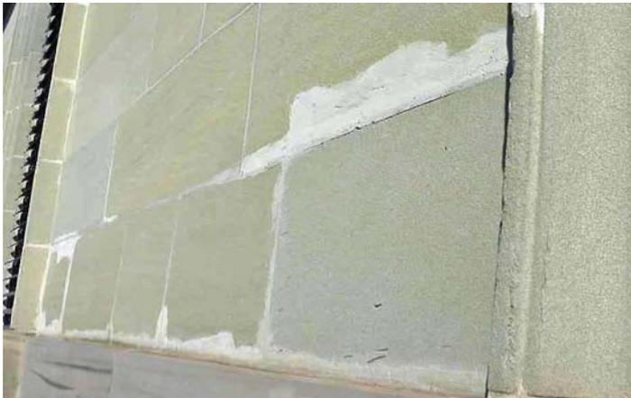
Ci-dessus, un exemple de parement (façade Sud) passablement rhabillé avec un mortier qui était très vraisemblablement correctement teinté couleur molasse à l'origine mais qui s'est « délavé » avec le temps, principalement par les UV. Cela montre, accessoirement, les limites du procédé de réparation avec du mortier en lieu et place d'un remplacement en pierre (massive ou par empieçement), dont la durabilité non seulement statique mais également chromatique est sans égal.
