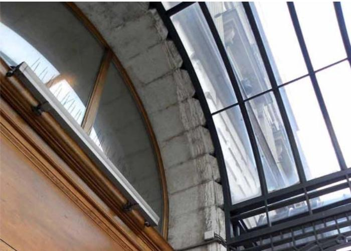
Ce calcaire dur, en tant que roche sédimentaire présente ponctuellement des strates composées de marnes et d'argiles terreuses qui ne se sont pas uniformément liées au reste des composants géologiques.
