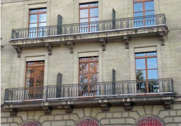
La photo ci-dessous révèle que des portions de la moulure inférieure du cordon sont encore en molasse ou dans une autre pierre tendre (grès des Vosges ?) alors que le reste est en ciment moulé.
