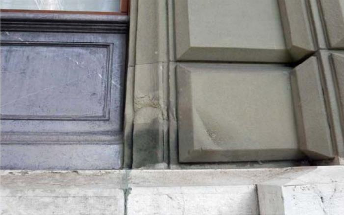
4. Les mortiers de rejointoiement et de rhabillages employés lors de la dernière restauration sont visiblement de duretés variables parfois un peu trop chargés en ciment, même si cette proportion n'est pas excessive. On constate en effet que sur l'ensemble, l'altération des parements en molasse ne se concentre pas systématiquement en périphérie des joints ou des réparations par rhabillage au mortier.
