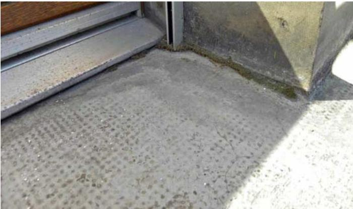
Ces problèmes d'infiltration d'eau ne datent visiblement « pas d'hier », compte tenu des dégâts que l'on constate sur les parements en molasse sous ce balcon. On voit même que des efflorescences sont apparues (=des sels, taches blanches sur la photo ci-dessous), signe qu'une forte humidité transite en permanence au sein même de la pierre et de la dalle en ciment.
