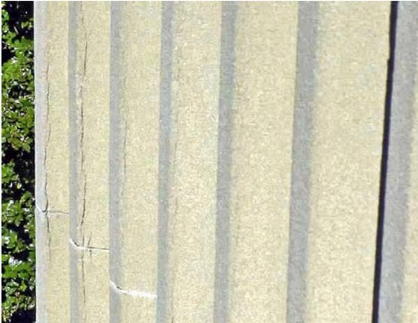
Ci-dessus, le pilastre à cannelures de l'angle Nord-ouest montre également ce type de fissures dues à la dilatation-contraction répétée de la pierre.
