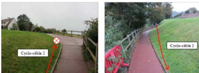
La longueur de la ligne est estimée à 104m, composée d'une partie en ligne et d'une autre en virage avec un rayon de courbure de 168m (= rayon minimum acceptable pour ce type d'installation).
